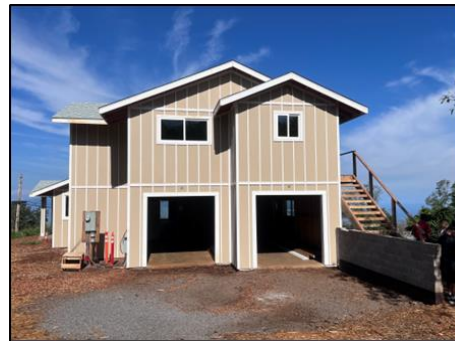
Kula Rebuild: September 2025
